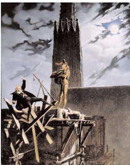
Meister Puchsbaum bricht am Baugerüst des Nordturms ein, um 1830, Franz Ritter von Hauslab
