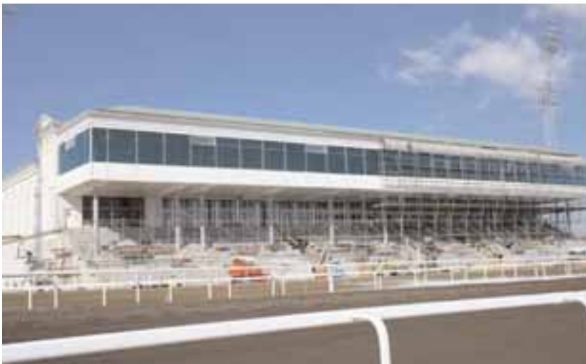
Das Hauptgebäude mit Tribüne beherbergt natürlich auch hochmodernste Technik
