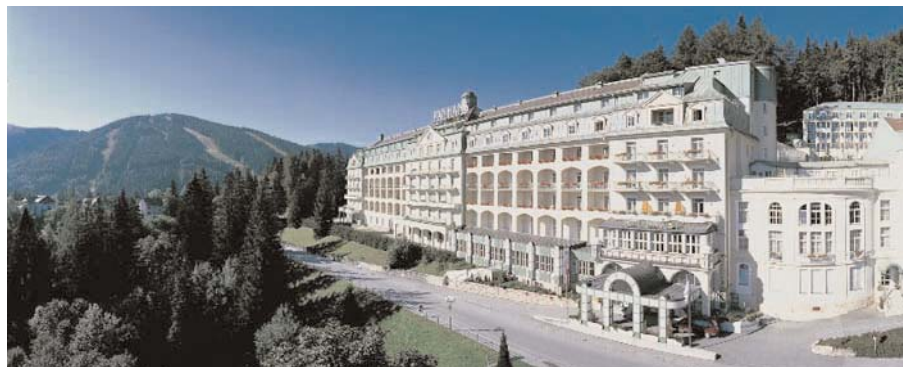
Franz Panhans gab 1912 den Auftrag sein Hotel durch einen 128 Meter langen Zubau zu vergrößern.
