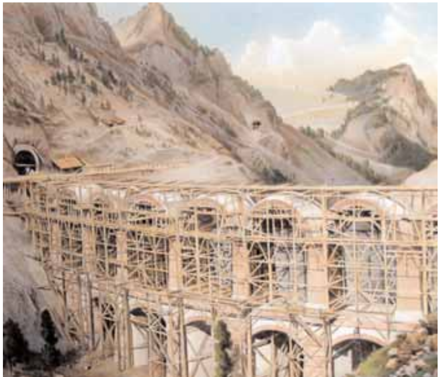
Blick auf die Eisenbahntrasse unter dem Adlitzgraben – die Gewölbe der oberen Bogenreihe sind bereits fertiggestellt, es fehlt nur der Aufbau zum Gleisbett
