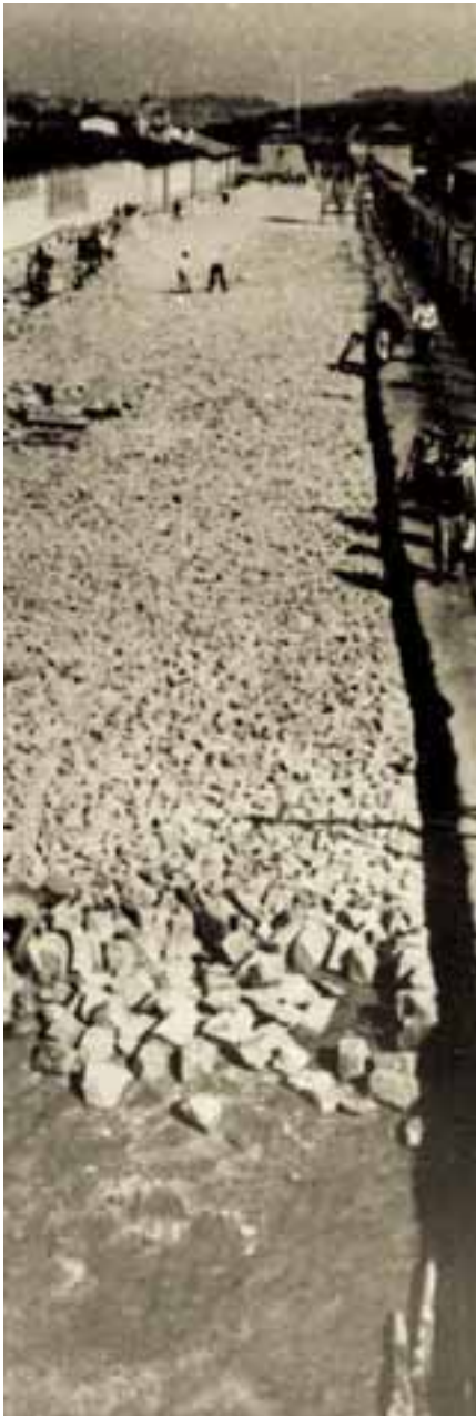
Aufbau des Appellplatzes Foto: Archiv MKÖ
