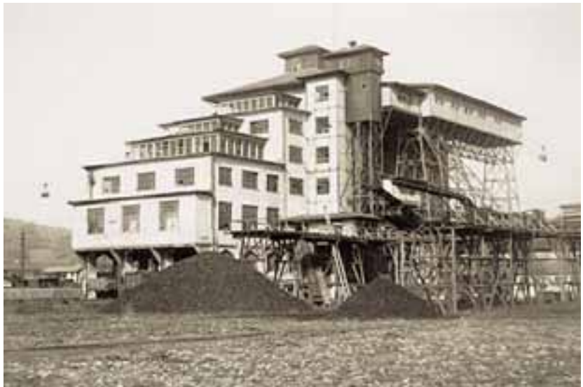
Die ehemalige Kohlesortierung ist das zentrale Ausstellungsgebäude
