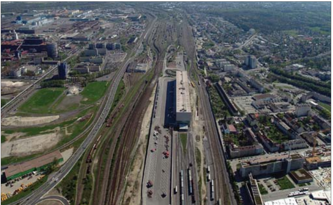
Das mit computergesteuerter Fördertechnik ausgestattete Rail Cargo Center hat eine Kapazität von 36.000 Paletten-Stellplätzen
