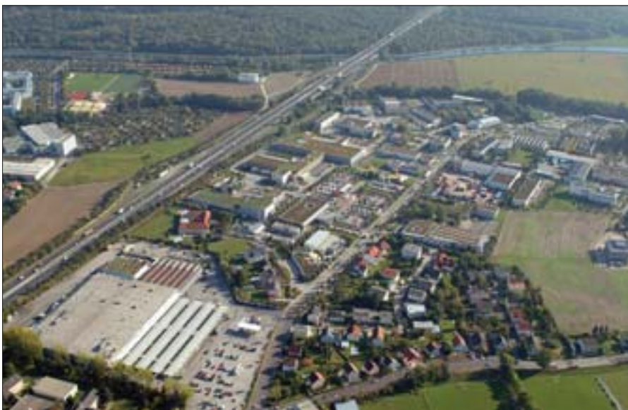
Nach den letzten Aussagen der Asfinag soll ab dem Jahr 2015 mit den Bauarbeiten für den dreispurigen Ausbau des Autobahnzubringers begonnen werden
