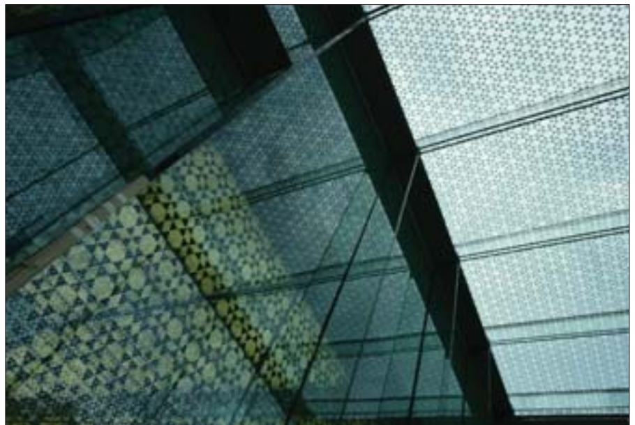
Der aus dem Hügel herauswachsende Bau des Foyers ist nicht nur mit Glas verkleidet, auch seine Tragelemente sind aus lamelliertem Glas.
