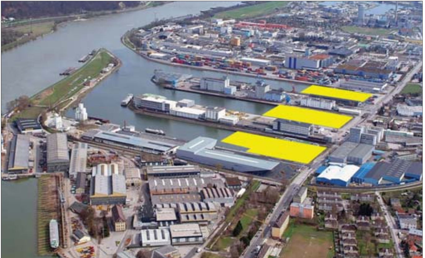
Die Linz AG plant eine Verlandung der drei Hafenbecken um jeweils etwa ein Drittel.
