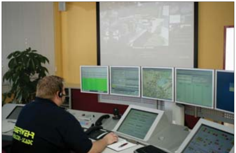
Mit der neuen Alarmzentrale – der mondersten Österreichs – sind 350 Brandmelder und eine Unzahl an Außenkameras verbunden
