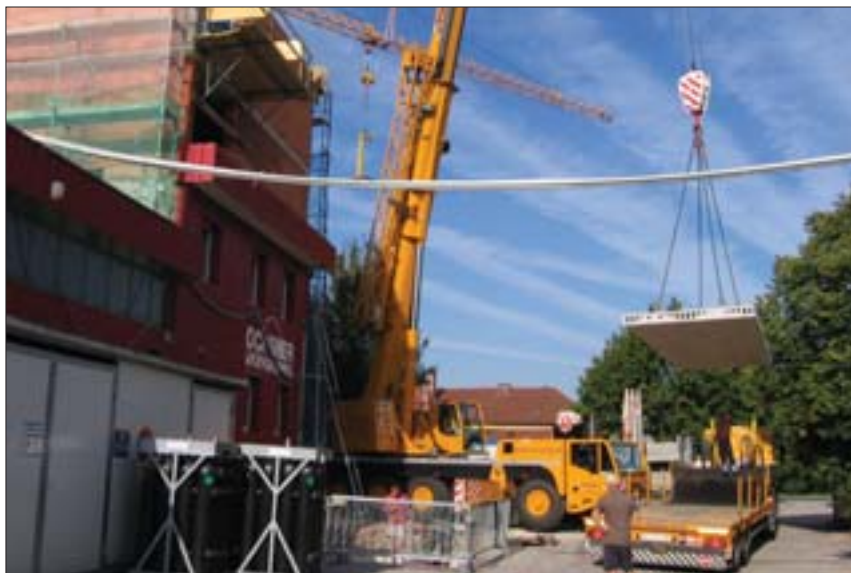
Volle Auftragsbücher erfordern den Ausbau des Entwicklungs- und Produktionsstandortes in Stadt Haag
