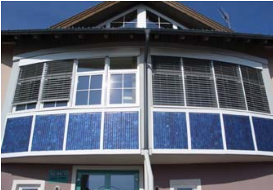
Fotos: Photovoltaik Austria
