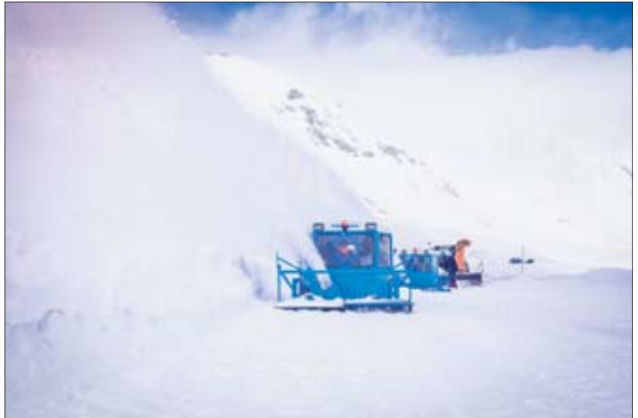
Schneeräumung der Großglockner Hochalpenstraße mit Durchstich
