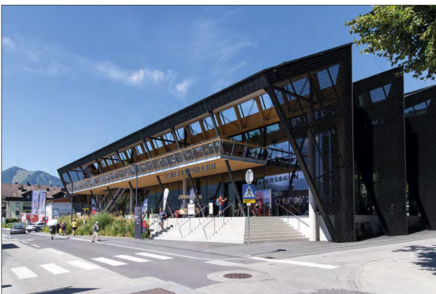
Straßenseitige Ansicht der neuen Talstation der Schafbergbahn
