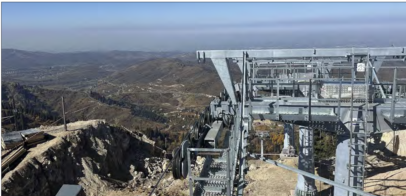
Blick von der entstehenden Bergstation auf 2.140 m Seehöhe auf die Stadt Almaty
