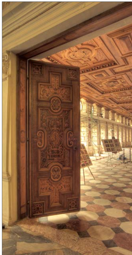
Beeindruckend sind die farbigen Einlegearbeiten der Holzdecke und -türen von Conrad Gottlieb
