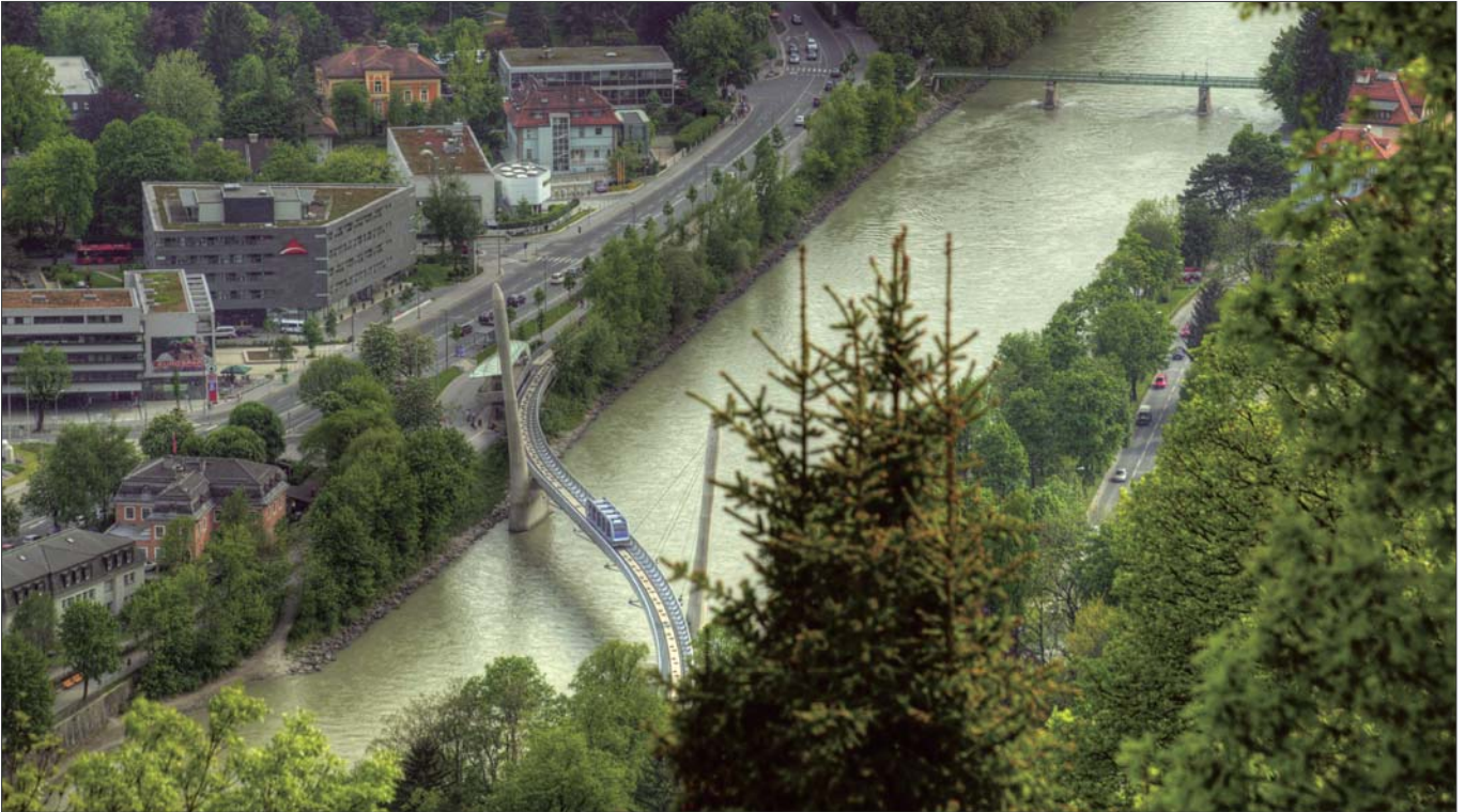
Von der Station Löwenhaus fährt die Bahn in einer S-förmig geführten Schrägseilbrücke mit zwei rund 30 Meter hohen Pylonen über den Inn in den Weiherburgtunnel. Die von Zaha Hadid geplante Brücke stellt eine architektonische Meisterleistung dar.
