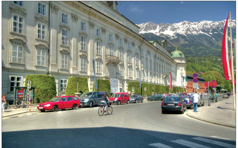
Die Prunkräume der Innsbrucker Hofburg wurden aufwendig renoviert ...
