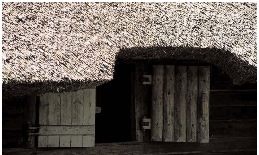
Detail der Bauweise: komplizierte Holzcharnieren und dicke Schilfdeckung
